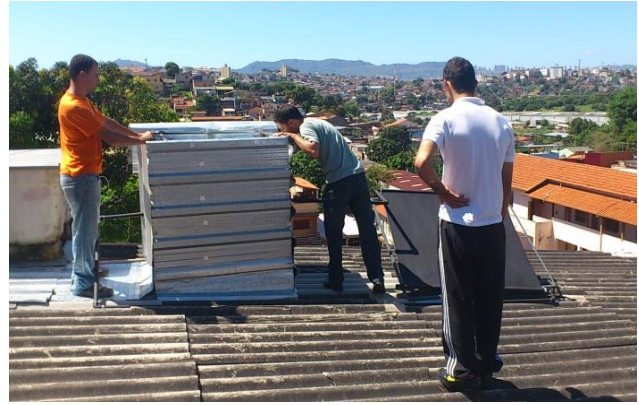
Fotos 10: Construção e instalação de aquecedor solar de baixo custo
